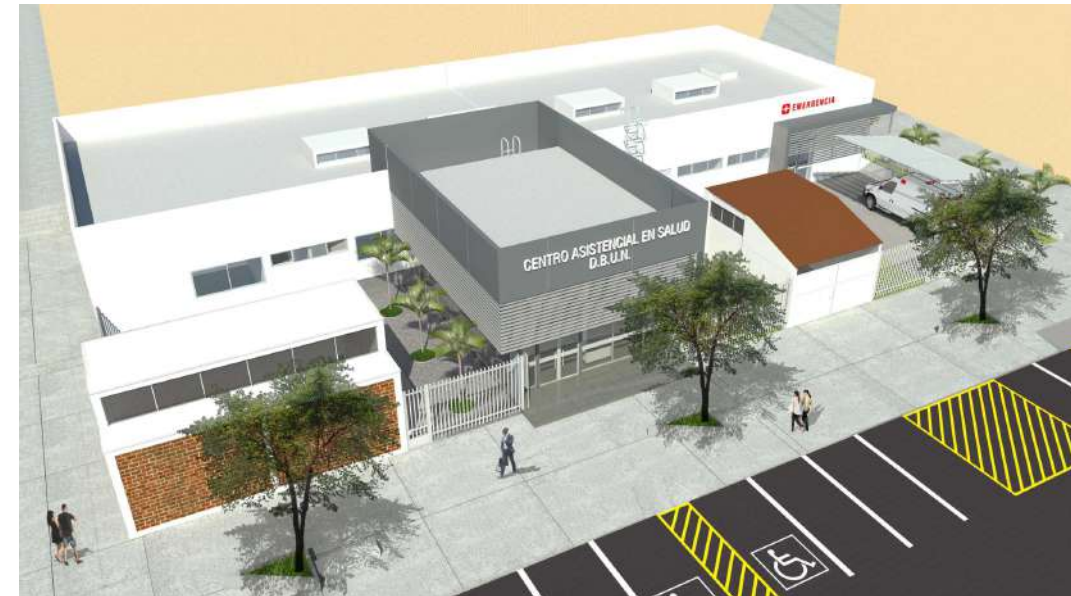
Figura 4 Vista Aérea Fachada SurOeste mostrando las teatinas
