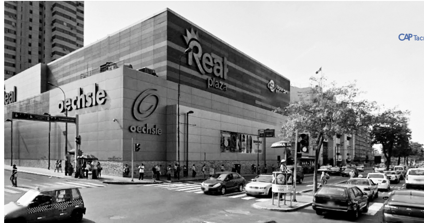
Figura 6 Centro Comercial Real Plaza, cruce de Bolivia con Garcilaso de la Vega, Fotografía: Vargas, C. 2016.
